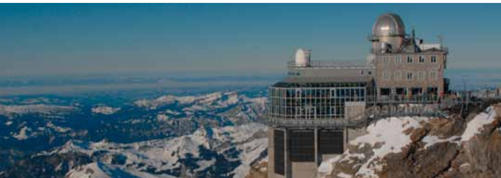
Sonnenkraftwerk der BKW-Tochtergesellschaft sol-E Suisse AG auf dem Jungfrauoch
